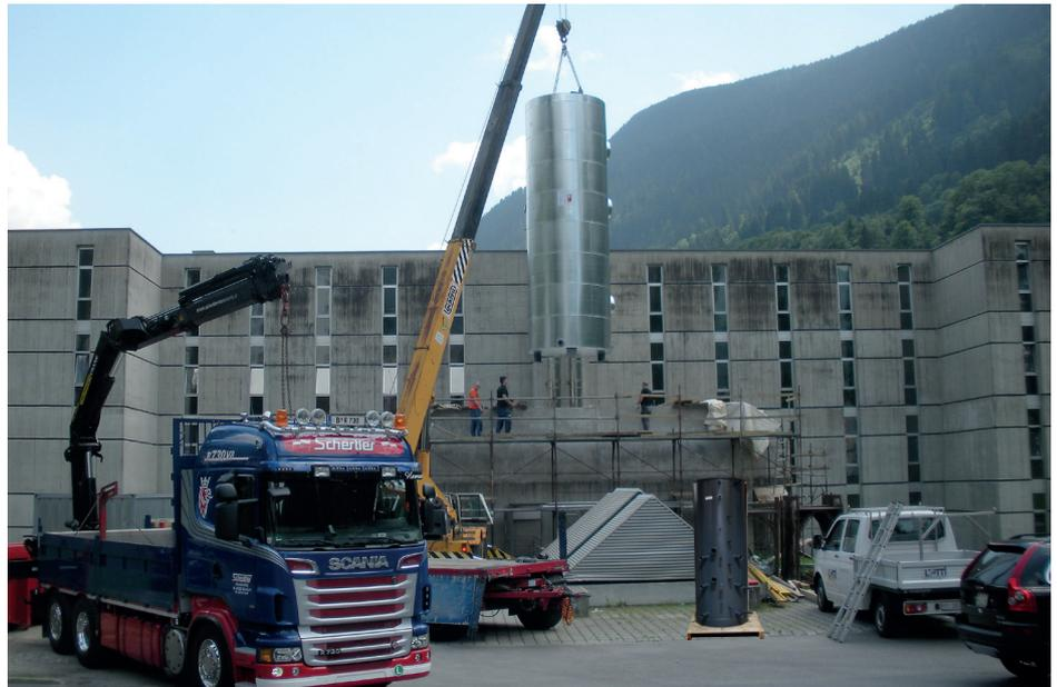
**Sonderisolierung** – Pufferspeicher, 26.000 Liter, 7.800 mm Höhe, werkseitige Isolierung mit 160 mm-Steinwolle-Schalenelementen und Außenhülle aus verzinktem Blech
