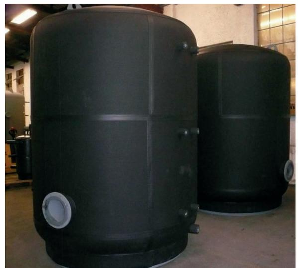
Kaltwasser-Puffer mit Armaflex-Isolierung
